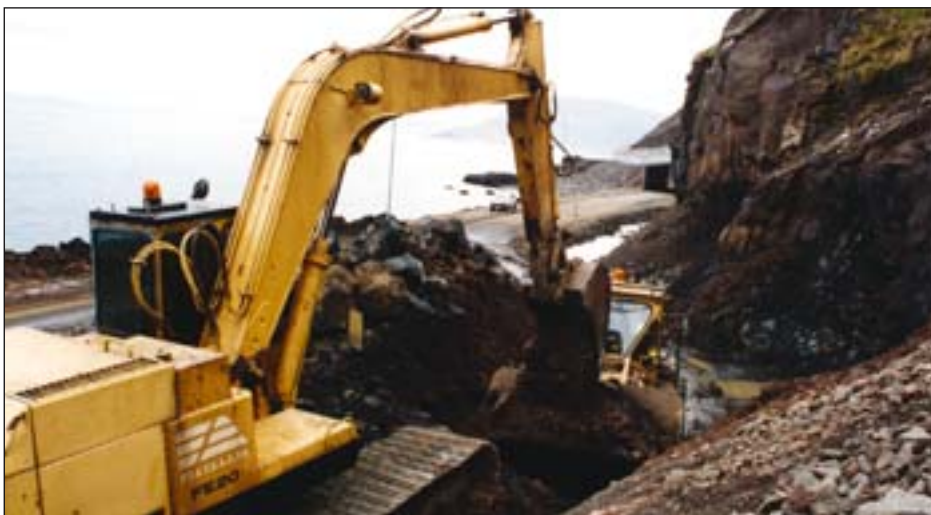
Framkvæmdir við gerð svokallaðra “snjóflóðaskápa” á Óshlíð í október 1998.
