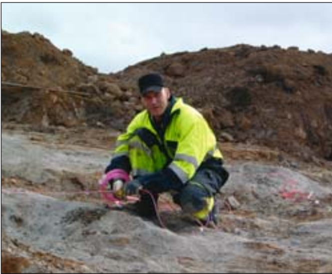
Helgi Mar við vinnu sína. Hér er hann að tengja saman sprengihleðslur í klöpp sem á að sprengja.
