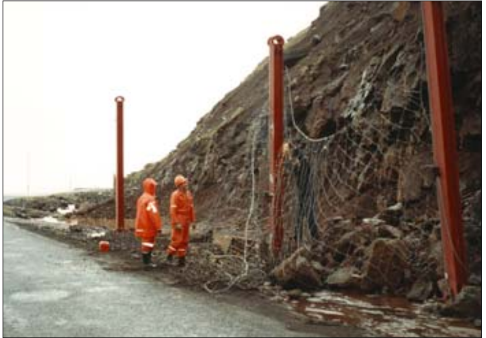
Starfsmenn Vegagerðarinnar kanna skemmdir á sundurtættu öryggisneti eftir grjóthrun á Óshlíð í júní 1992. Annar frá vinstri er Ólafur Vilhjálmsson veghef-ilstjóri Vegagerðarinnar á Ísafirði til fjölda ára.
