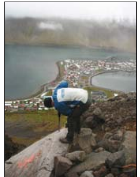
Það voru sannarlega glæfralegar aðstæðurnar við sprengivinnu á Gleðarhjalla 2005 og svimandi hátt niður á Hjallaveg og Hlíðarveg fyrir neðan. Mynd Rúnar Óli Karlsson.
