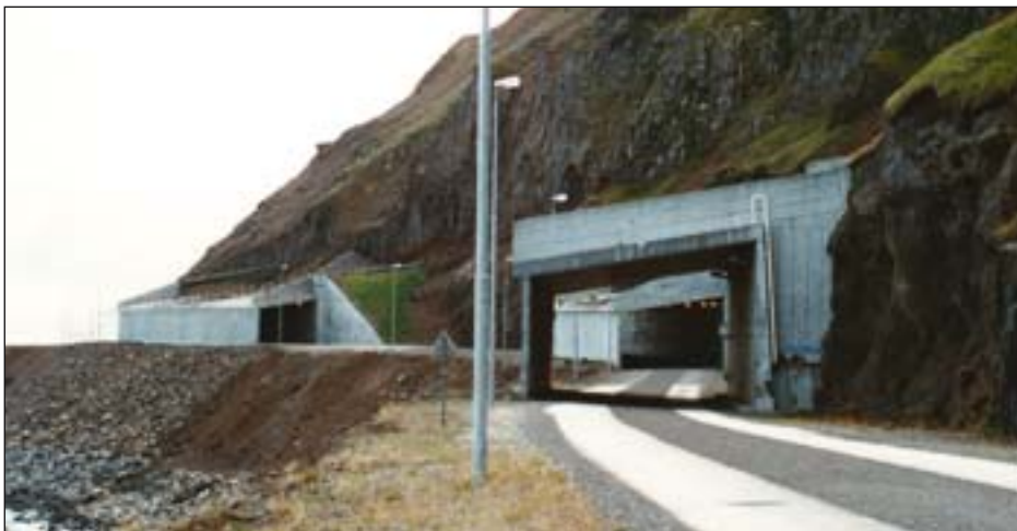
Þrennar vegsvalir undir hættulegum giljum á Óshlíð. Vegsvalirnar hafa margoft sannað gildi sitt en duga þó ekki til að tryggja öryggi vegfarenda um veginn vegna grjóthruns á óvörðum svæðum.
