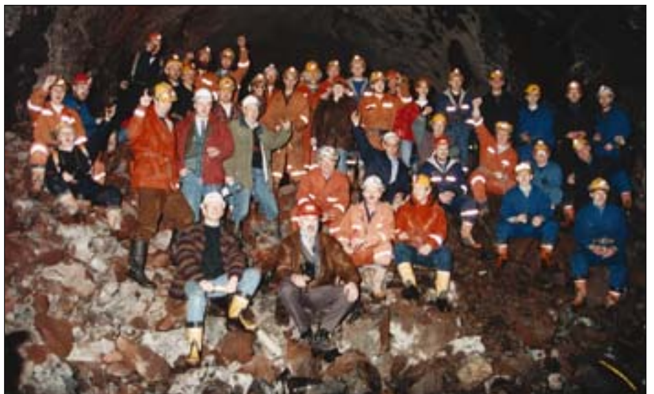
Starfsmenn verktaka fagna sprengingunni sem opnaði síðasta haftið á Flateyrarlegg Vestfjarðaganga. Að vísu sögðu ódannaðir starfsmenn að nóttina áður hafi verktakarnir sprengt í gegn í hreinum ákafa, en mokað hafi verið upp í gatið aftur svo ráðherrann hefði eitthvað til að sprengja.
