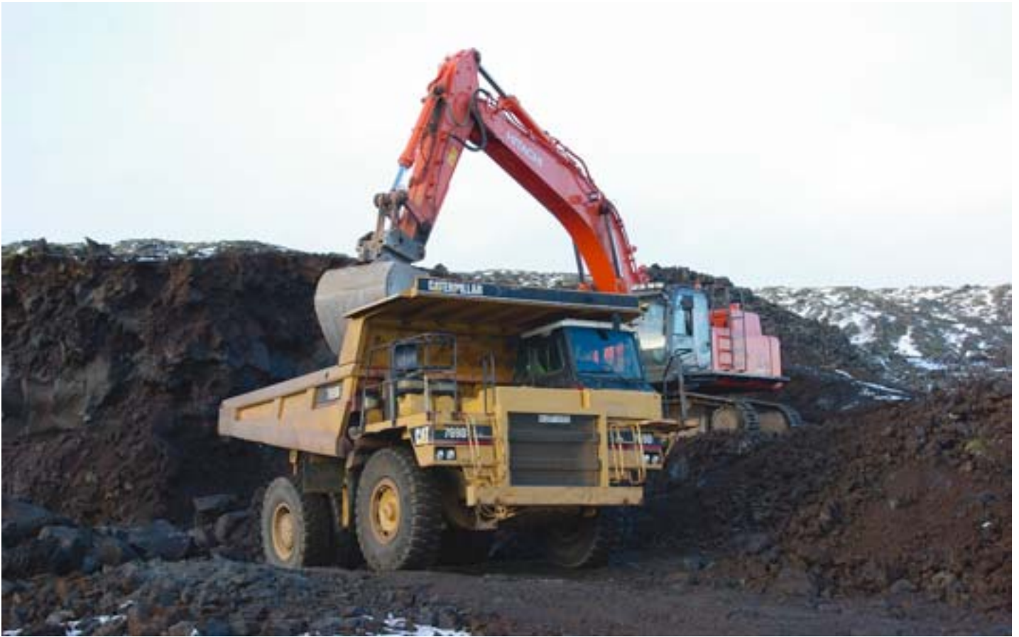
Frá framkvæmdunum við Suðurstrandarveg 28. febrúar 2009. Mynd: Hörður Kristjánsson.
