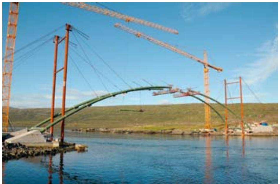
Vegagerðin í Ísafjarðardjúpi með þverun Mjóafjarðar er mikið verk, en því lýkur í sumar. Þá þykir bogabruin sérlega athyglisverð, en hér er verið að hífa síðustu stykkinn í bogana. Mynd: KNH.
