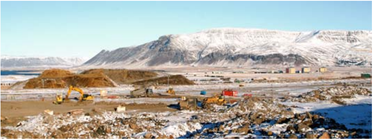
Unnið við að grafa grunn undir hið nýja Korputorg (sem gárungarnir kalla Krepputorg) í Stekkjabrekkum veturinn 2005. Mynd: Hörður Kristjánsson.
